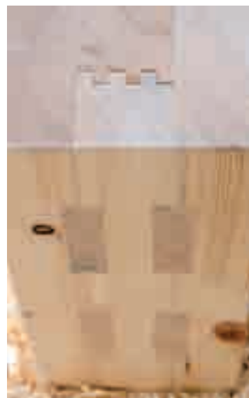
Aufbau Massivholzwand mit Gratleisten
