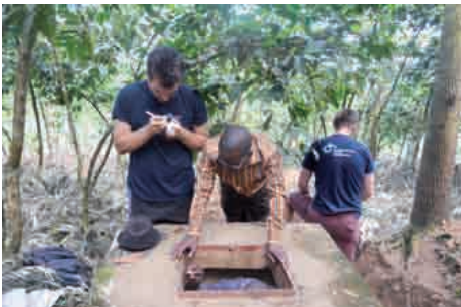
Bild 2: Besuch der Bergquelle mit Probenahme und Inspektion der Leitungen.
