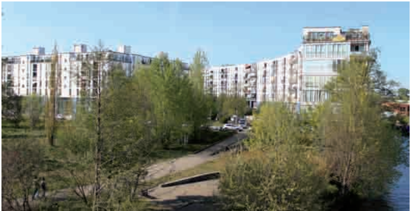
Geschosswohnungsbau nach Abschluss der Entwicklungsmaßnahme
