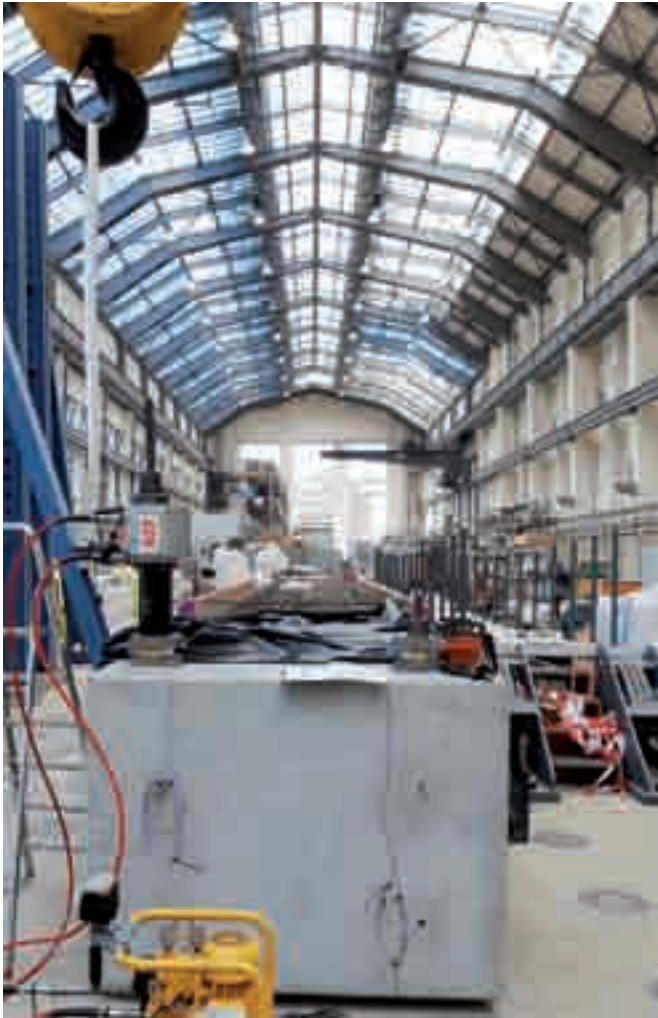
Abb. 6 Vorspannen der Widerlager mit zwei Spannstrangen
