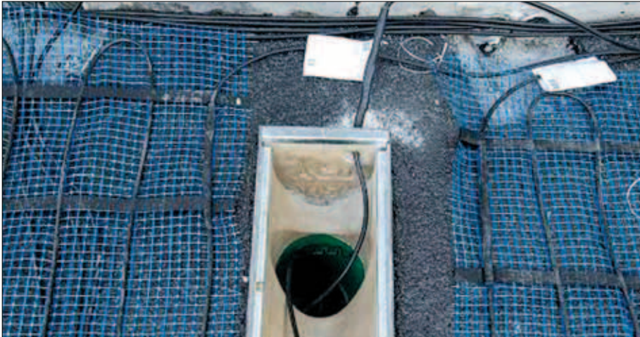
In den Ablaufrinnen werden zusätzlich AEG Heizkabel verlegt und mittels PE-Stegen fixiert. Damit das Tauwasser frei ablaufen kann, wird das Heizkabel etwa einen Meter tief in das Ablaufrohr geführt.
