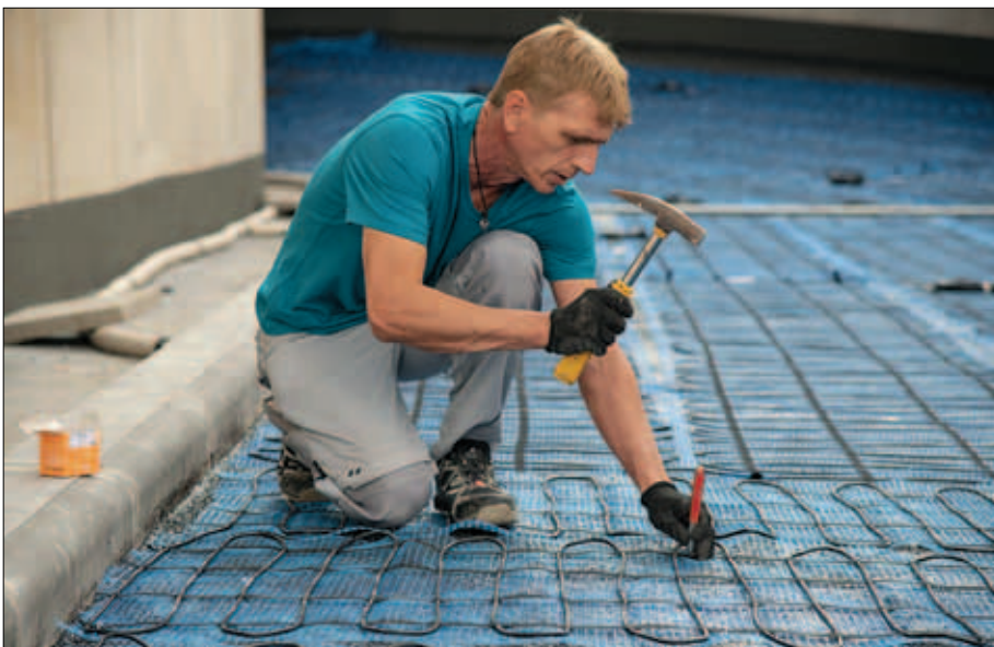
Bei der Befestigung der Heizmatten auf dem Untergrund darf der Heizleiter nicht beschädigt werden – nur das Trägerband der Heizmatte wird mit einem Dübel, Nagel oder Bolzenschussgerät fixiert.
