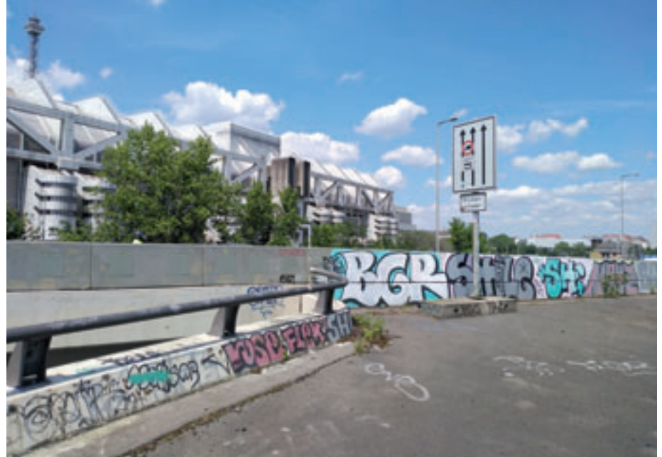
Das gesamte Autobahndreieck Funkturm ist stark erneuerungsbedürftig. Die Zufahrt vom Messedamm Höhe ICC zur A 100 Fahrtrichtung Nord musste schon vor Jahren geschlossen werden.
