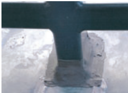
Bilder 2 und 3: Weder Kompriband noch Silikon sind hier fachgerechte Abdichtungen
