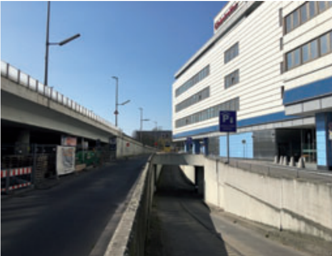
Im Zentrum von Steglitz: rechts der Steglitzer Kreisel, links die Stadtautobahn Westtangente, darunter der Zugang zum S-Bahnhof Steglitz. Foto: HB 2020
