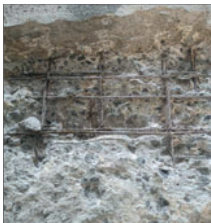
Korrosionsschäden im Beton.
