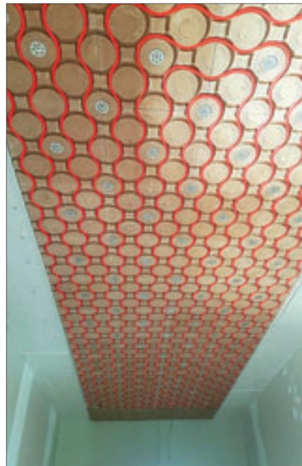
Kühldecke vor der Oberflächenbeschichtung.
