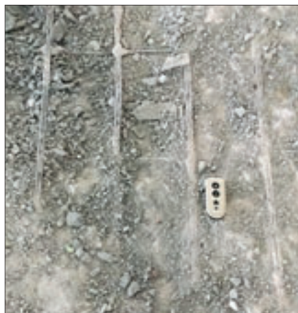
Korrosionsschäden im Beton.
