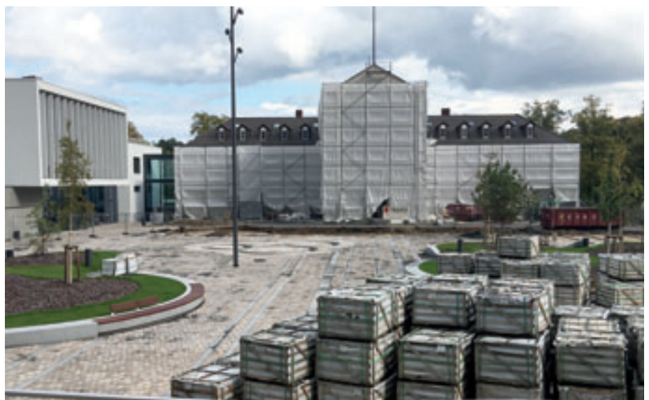
Das Rathaus von Hohen Neuendorf im Norden von Berlin, links der neue Erweiterungsbau. Eine umfassende Gestaltung des Zentrums steht noch aus. Foto: HB 2019
