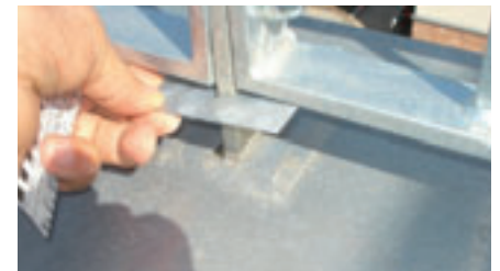
Bilder 6 und 7: Anschluss Abdichtung und fertige Situation mit Blechabdeckung
