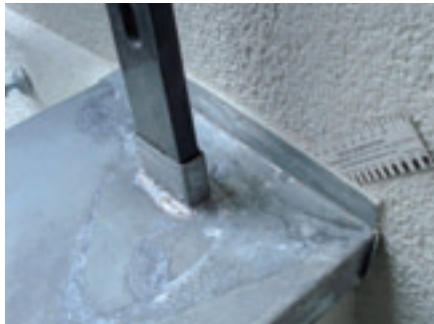
Bilder 2 und 3: Weder Kompriband noch Silikon sind hier fachgerechte Abdichtungen
