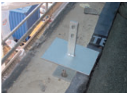
Bild 5: Anschluss Abdichtung und fertige Situation mit Blechabdeckung
