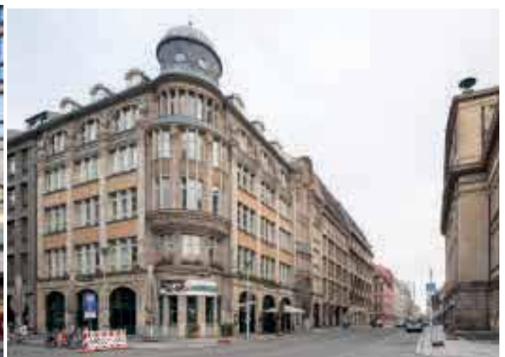
Funktionsgebäude für das Schauspielhaus und die Hochschule für Musik, 1978-88 von Manfred Prasser, Peter Kobe und Ernst Wallis, (Landesdenkmalamt Berlin, Anne Herdin).
