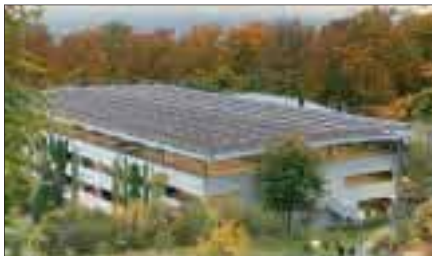
Die neue Solaraufständerung OPTIGRÜN-SOLAR FKD auf dem EMBL-Parkhaus in Heidelberg.
