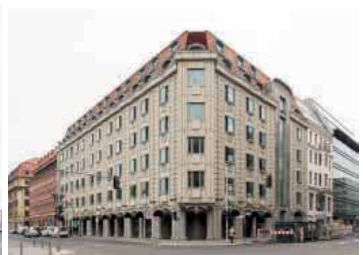
Internat der Akademie für Gesellschaftswissenschaften, 1980-83 von Manfred Prasser, Ernst Wallis, Wolfgang Sebastian und Dieter Bankert (Landesdenkmalamt Berlin, Anne Herdin).
