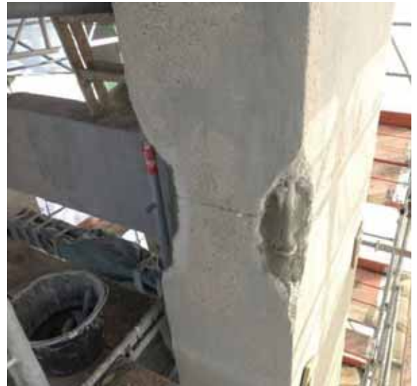
Abbildung 14: Entrosten des Bewehrungsstahls und Aufbringen einer Haftbrücke
