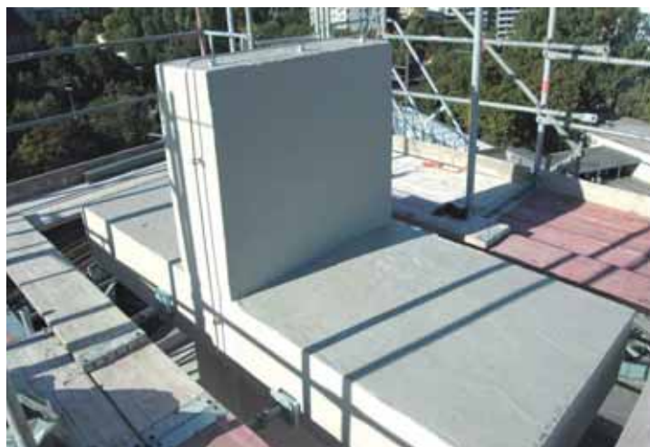
Abbildung 12: Herstellen der Beschichtung inklusive eines Gefälles der horizontalen Flächen
