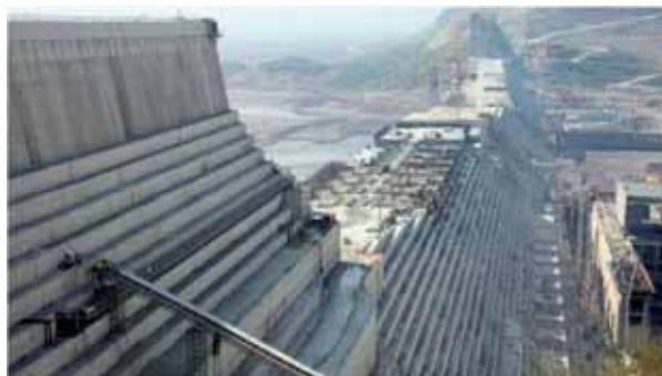
Abbildung 1: GERD im Bau (links), Drei-Schluchten-Talsperre (unten)
