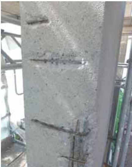
Abbildung 13: Freilegen der Bewehrung an einer Schadstelle nach Abklopfen und Stemmen
