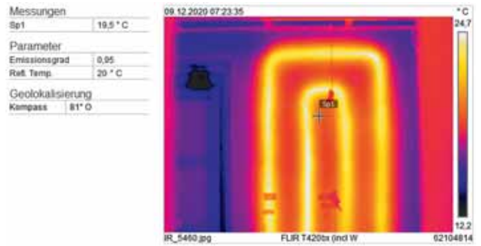
Abb. 7: Thermografie Außenwand (Heizleitungen) © EffTecSo
