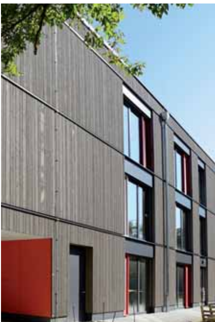
Angenehmer Kontrast: Fassade in silbergrau lasierter Douglasie und Wand- und Fensterelemente in Rot
