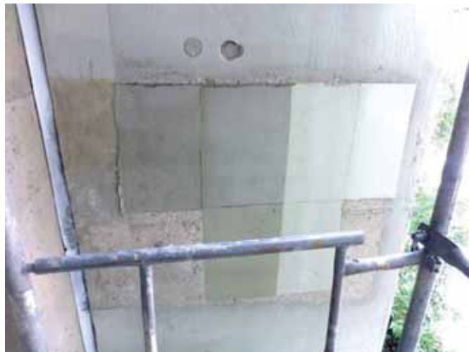
Abbildung 10: Ansicht von angelegten Musterflächen mit unterschiedlichen Schichtaufbauten.
