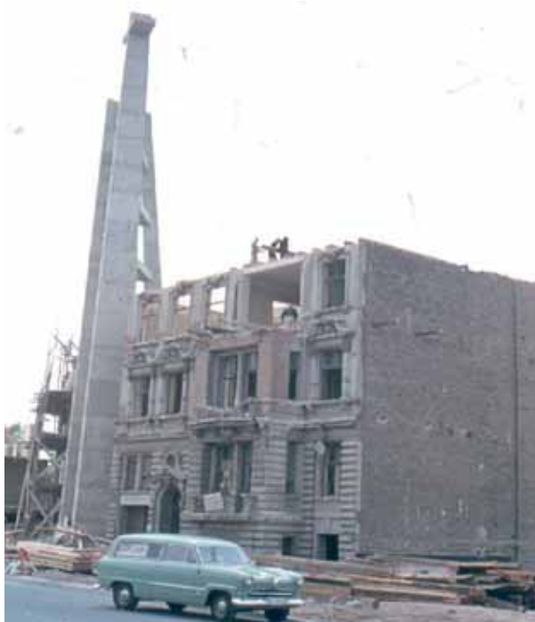
Abbildung 3: Errichtung des Glockenträgers bei gleichzeitigem Rückbau des Nachbargebäudes [1]
