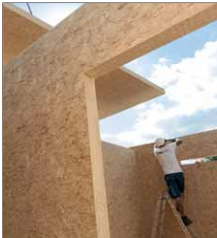
Massive Wand- und Deckenelemente aus SWISS KRONO MAGNUMBOARD® OSB (Bildnachweis: © SWISS KRONO / Foto: Andrea Kroth)
