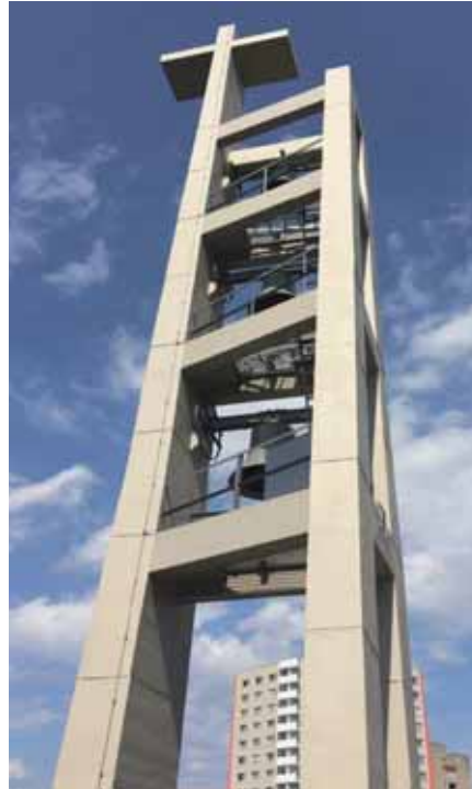
Abbildung 18: Ansicht des Glockenträgers. Deutlich wieder zu erkennen sind die Arbeitsfugen.
