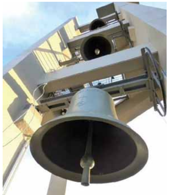
Abbildung 17: Ansicht der drei Glockenebenen vor Anbringen der Geländer
