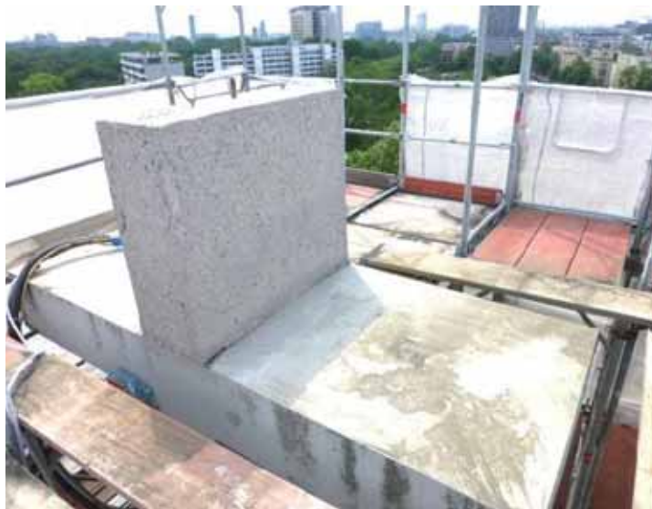
Abbildung 11: Freilegung der Oberfläche des Bestandsbetons
