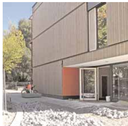
Ein Bauzaun sorgt für die nötige Sicherheit.
