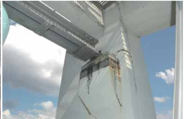
Abbildung 6: Schäden an der Konsole der Glockenauflagerung
