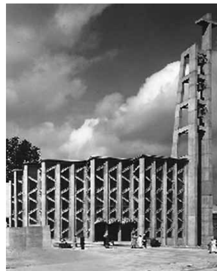
Abbildung 2: Aufnahme der Kirche St. Ansgar mit dem Glockenträger rechts [1]. Deutlich zu erkennen sind die Arbeitsfugen.
