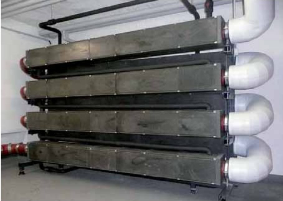
Bild 3: Abwasserwärmeübertrager (Fa. PEWO Energietechnik) Bild PEWO Energietechnik
