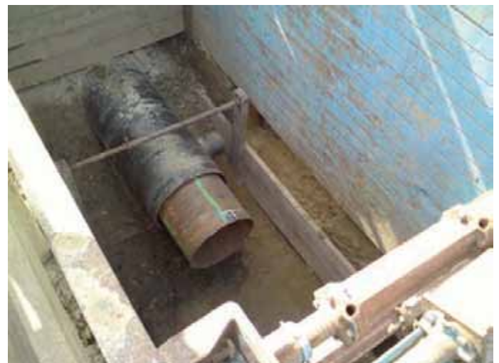
Bild 6: Doppelmantel-Wärmeübertrager, erdverlegt Bild Ingenieurbüro Lang
