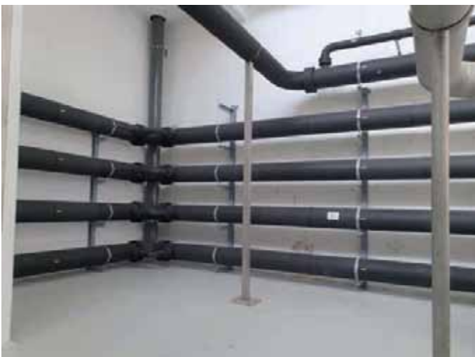
Bild 5: Doppelmantel-Wärmeübertrager als Wandmontage innerhalb eines Abwasser-Pumpwerkes Bild Ingenieurbüro Lang
