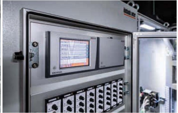
Die DDC4000 sammelt die Daten aller Feldgeräte, regelt die HLK-Anlagen und gibt die Informationen an das BMS weiter. Über den Farbtouchscreen wird die DDC vor Ort bedient. Unten im Bild: Handbedienebene eines ASPs für den Havariefall
