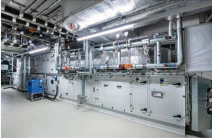
Das Lüftungsgerät der Vollklimaanlage im Humboldt Forum (komplett mit allen Ansteuerungen) kann je nach Bedarfslage und Jahreszeit heizen oder kühlen, hauptsächlich um die konservatorischen Werte der Temperatur und Feuchte zu erhalten.
