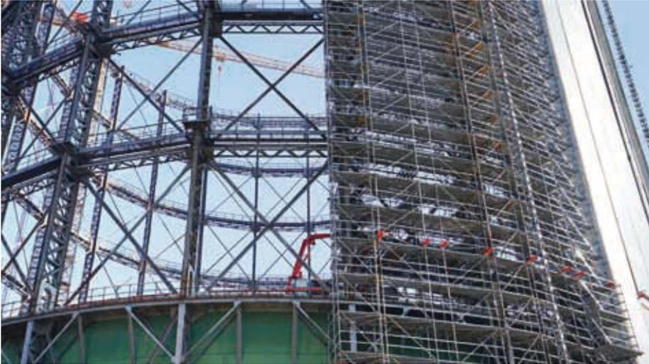
*Gerüst und Einhausung sind der Form des Gasometers angepasst, ermöglicht ein sicheres und komfortables Arbeiten und wandert abschnittsweise um das Bauwerk mit.*
