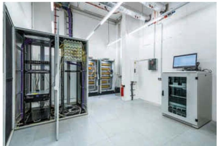
Im Keller des Humboldt Forum steht der Serverschrank mit der Hardware und Software für das Hochleistungs-BMS. Rechts im Bild: Serverschrank und hinten im Bild: Übergabeschränke und Brandmeldezentrale zur Entrauchungssteuerung:
