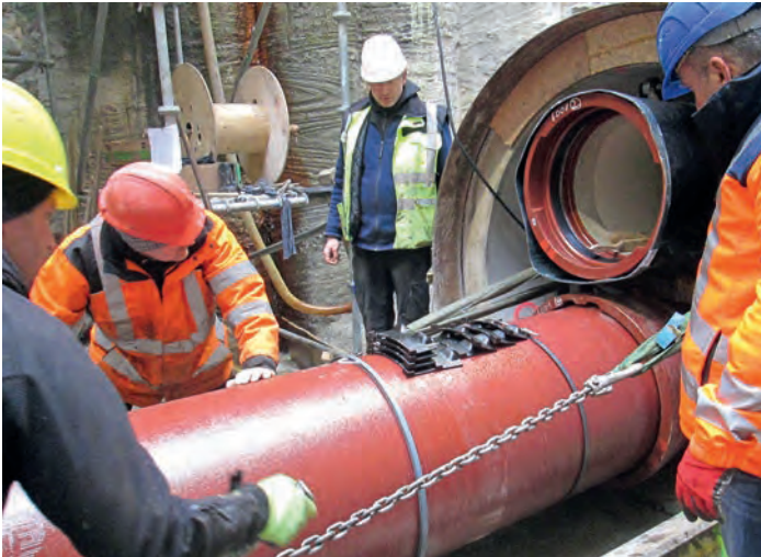
Bild 2: Einsatz duktiler Gussrohre mit längskraftschlüssigen Verbindungen.
