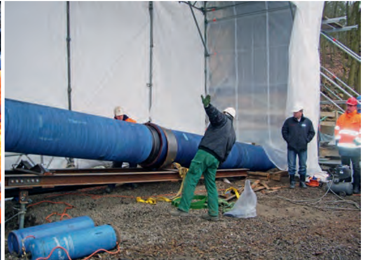
Bild 3: Erneuerung der Rohwasserleitung der Brunnengalerie „Schildhorn“.
