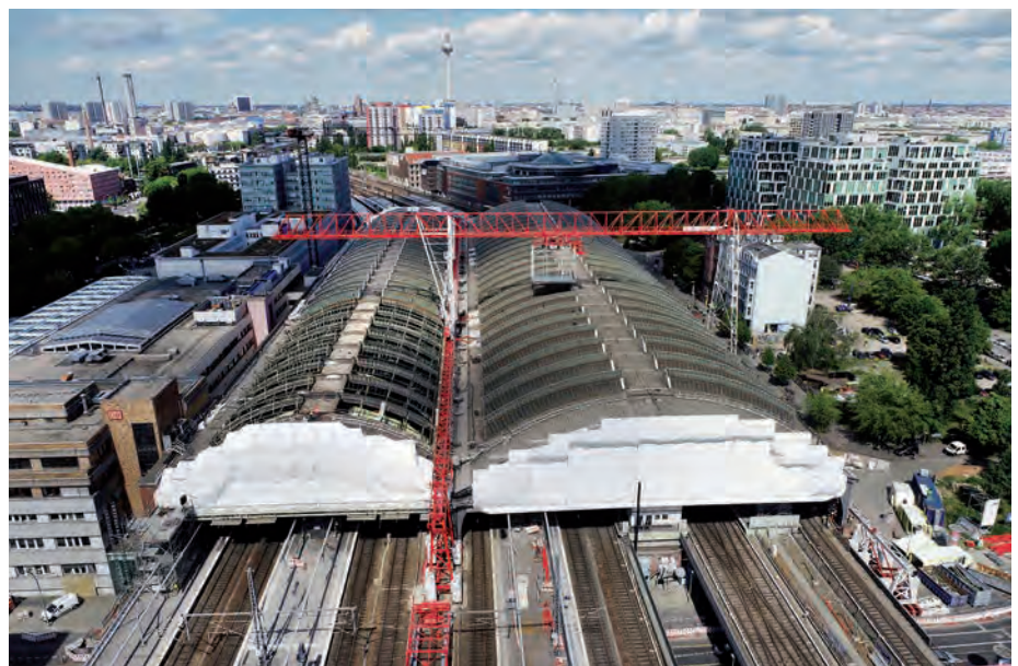
Blick von oben auf die Gleishallendächer (Mai 2022)
