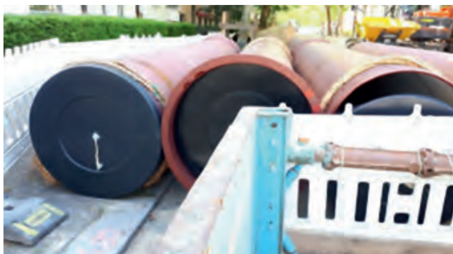
Bild 10: Rohre DN 1000 mit BLS-Verbindung in der Bergstraße (Berlin-Steglitz).
