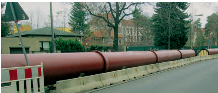
Bild 7: Abschnittsweise Dichtheitsprüfung der Interimsleitung.
