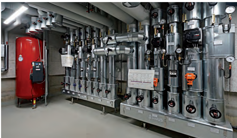
Moderne Wärmepumpen basieren heutzutage vorwiegend auf erneuerbaren Energien.
