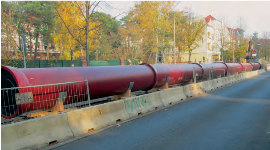
Bild 6: Interimsleitung in der Hermann-Hesse-Straße.
