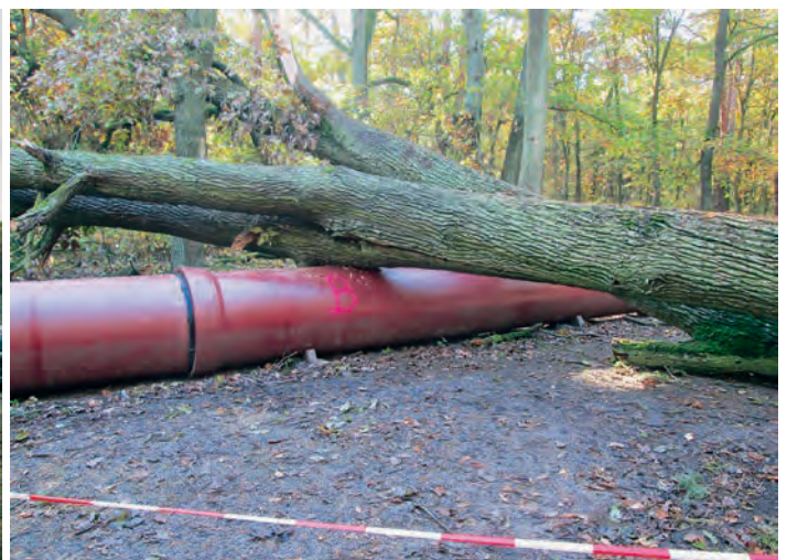
Bild 5: Entwurzelte Eiche hat keinerlei Schaden an der Interimsleitung verursacht.
