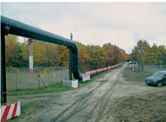
Bild 4: Rohrbrücke aus Stahlrohren sichern die Zugänglichkeit.
