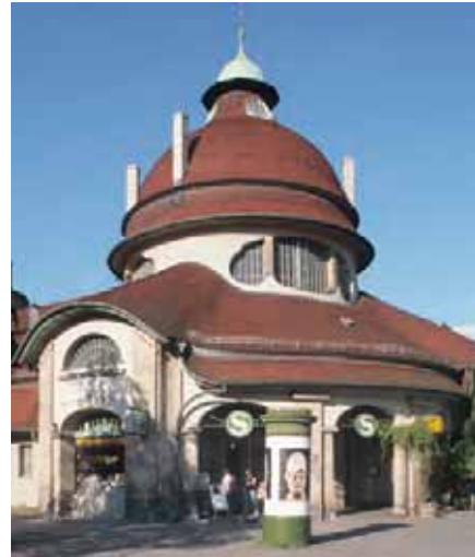
Abb. 18: Aufwändig ausgebildetes Dach des S-Bahnhofs Mexikoplatz
