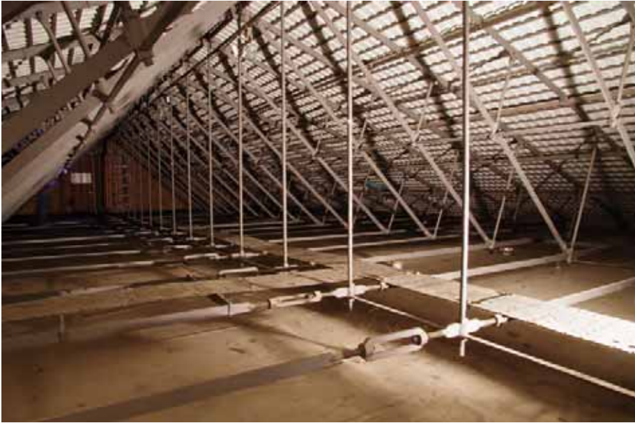
Bild 5: Neue Eremitage, Dachtragwerk über dem Rembrandtsaal (Heres 2011)
