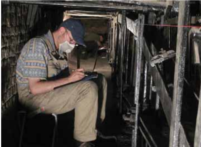
Bild 8: Konstruktive Bestandsaufnahme mit Handaufmaß, hier in der Decke über dem Wappensaal (Heres 2009)
