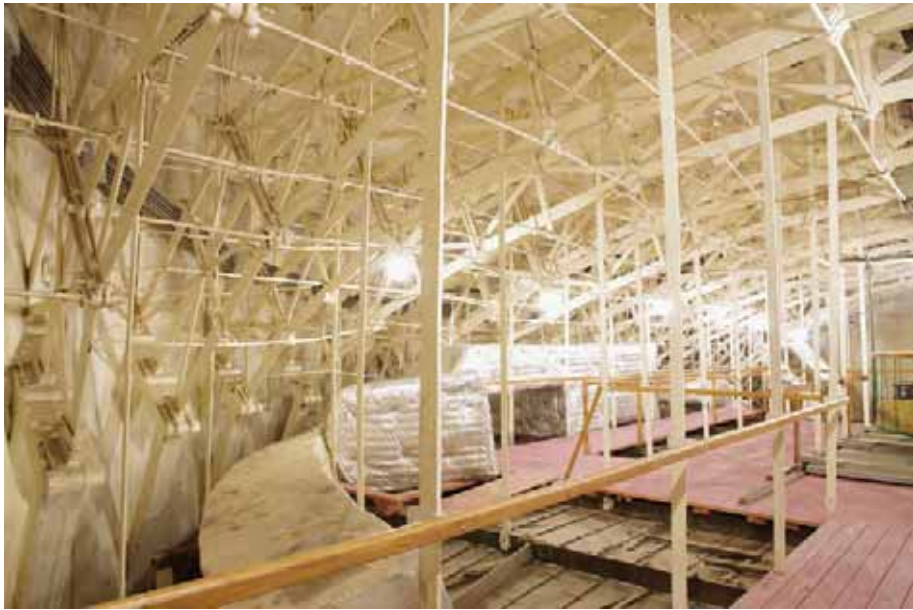
Bild 13: Aleksandrinskij-Theater, Deckentragwerk über dem Zuschauerraum (Heres 2016)
