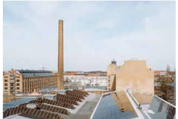
Abb. 5: PV-Anlagen auf denkmalgeschützten ehemaligen Fabrikgebäuden
