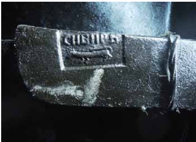
Bild 14: Winterpalast, Deckentragwerk über dem Wappensaal, Eisenstempel „Alter Zobel“ mit Tiersymbol und der Inschrift „SIBIR“ (Heres 2012)
