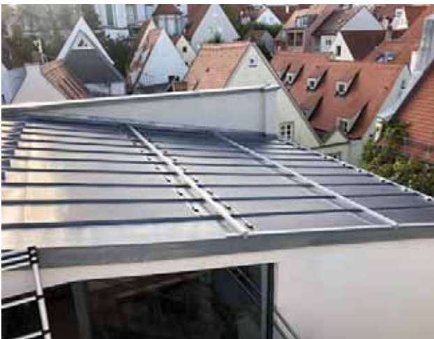
Abb. 10: Durch ein Glasfaserträgermaterial sind die Module auf diesem Metaldach besonders dünn und leicht
