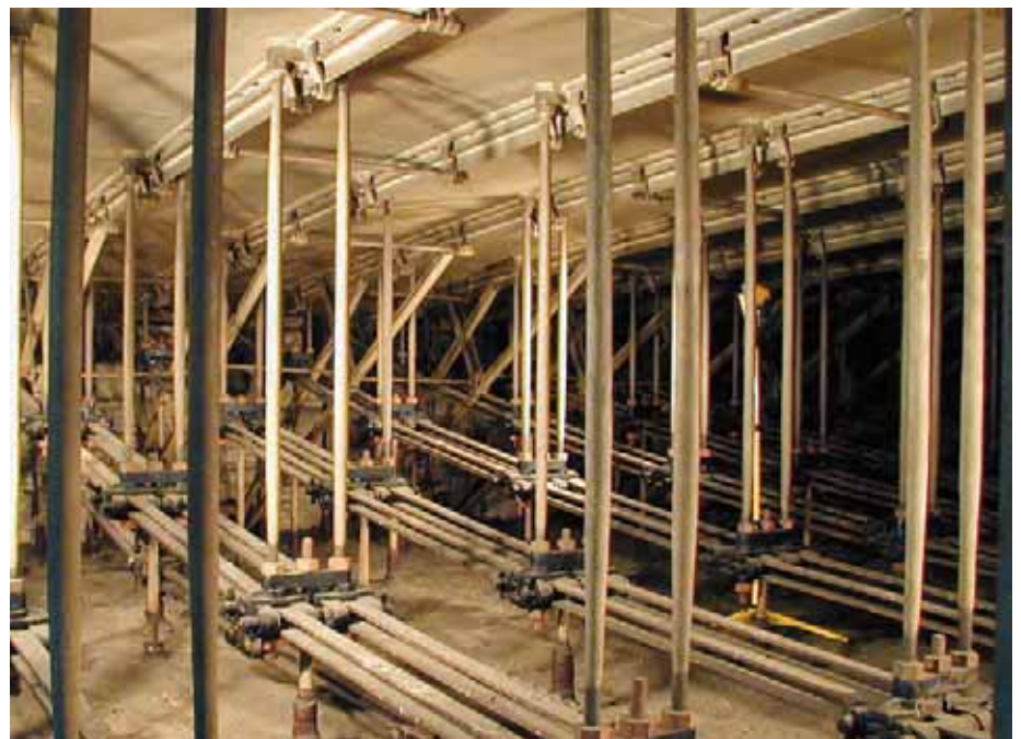
Bild 7: Winterpalast, Deckentragwerk über dem Thronsaal (Heres 2009)
