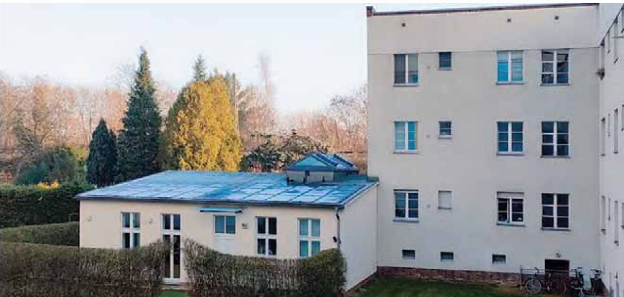
Abb. 12: Das Dach eines denkmalgeschützten Nebengebäudes ist aus dem halböffentlichen Raum einsehbar. Die Sichtbarkeit konnte durch eine PV-Anlage mit flachen Modulen reduziert werden
