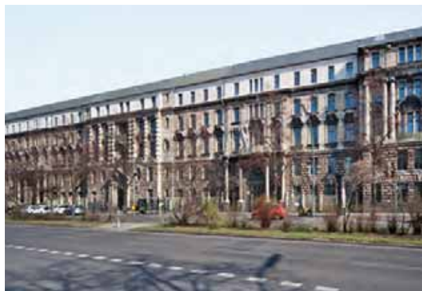
Abb. 6: Denkmal mit überformtem, nicht bauzeittypischem Dach
