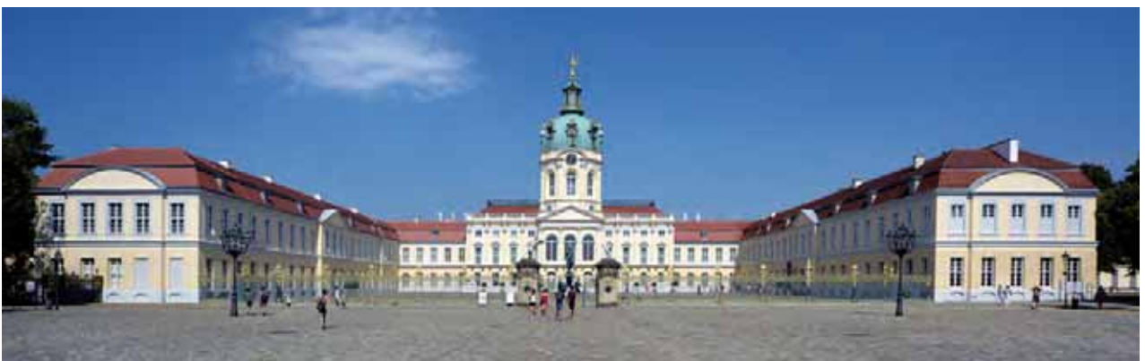
Abb. 17: Dachflächen der weithin sichtbaren Schlossanlage Charlottenburg
