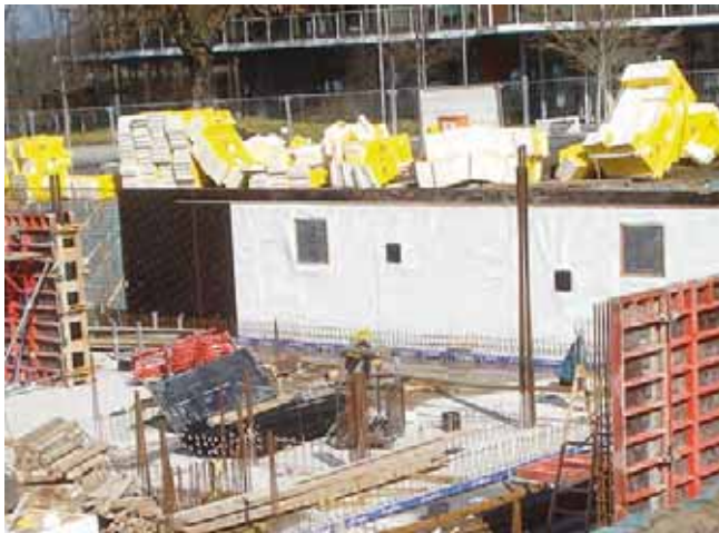
Bild 3: Verlegen Frischbetonverbundfolie nur an später nicht zugänglichen Keller- Wandbereichen
