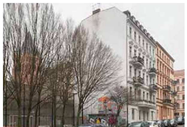
Abb. 7: Brandwand in einem Denkmalbereich
