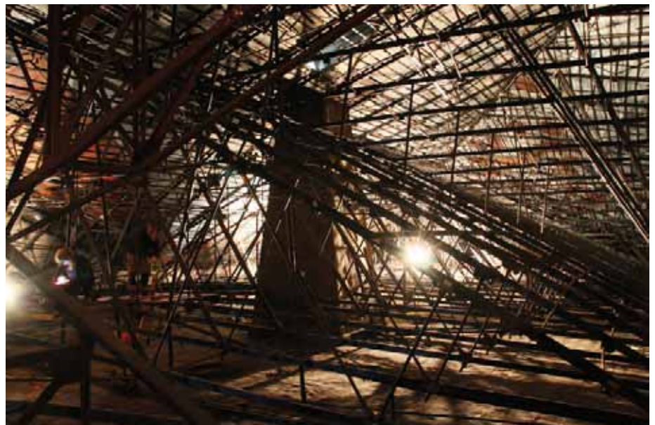
Bild 4: Winterpalast, Dachtragwerk über dem Feldmarschallsaal (Heres 2009)
