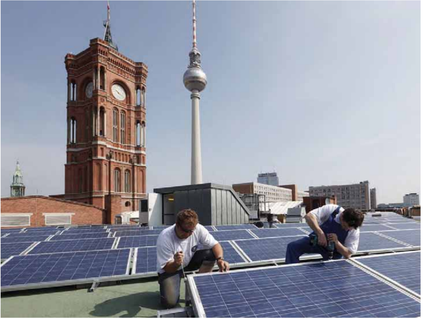
Errichtung der Photovoltaikanlage auf dem Roten Rathaus
