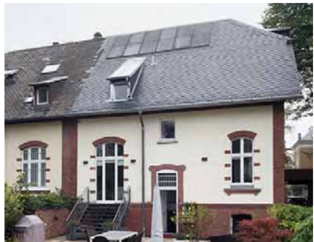
Abb. 11: Farbliche Anpassung einer PV-Anlage an die Dachdeckung durch Auswahl monochromer, matter Module
