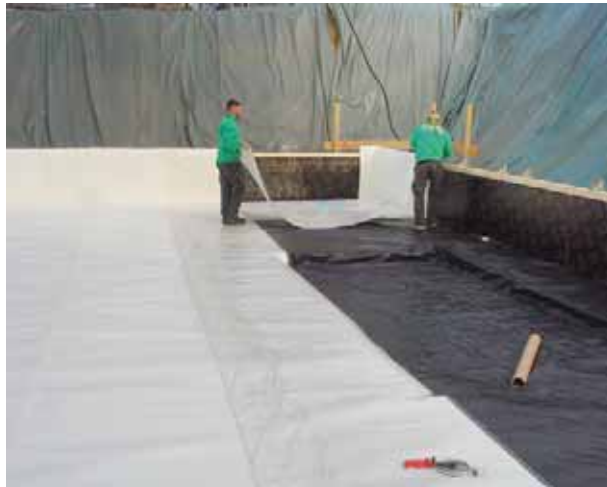
Bild 2: Verlegen Frischbetonverbundfolie - Sohle
