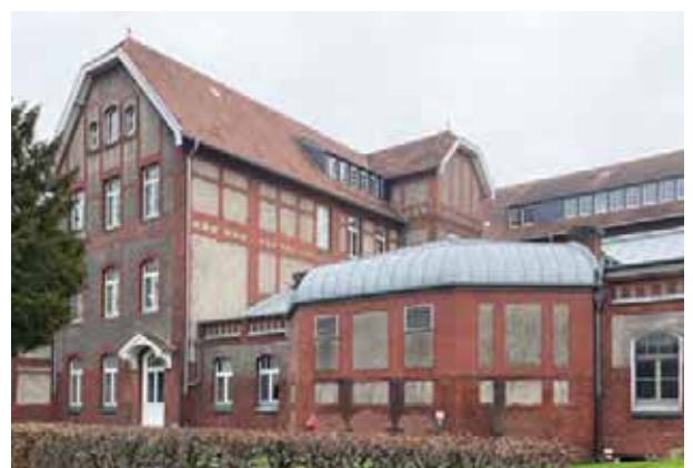
Abb. 4: Die Dachfläche ist nur vom halböffentlichen Bereich aus zu sehen
