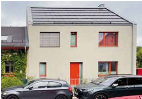
Abb. 8: Dachintegrierte PV-Anlage auf Neubau neben einem Denkmal
