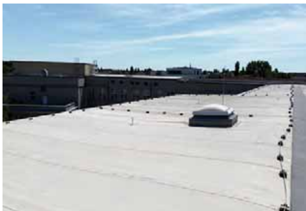
Abb. 1: Flachdach der Hochschule für Technik und Wirtschaft
