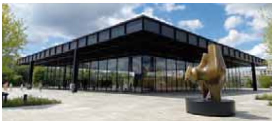
Die Sanierung der neuen Nationalgalerie ist Folge 3 des Podcasts.
