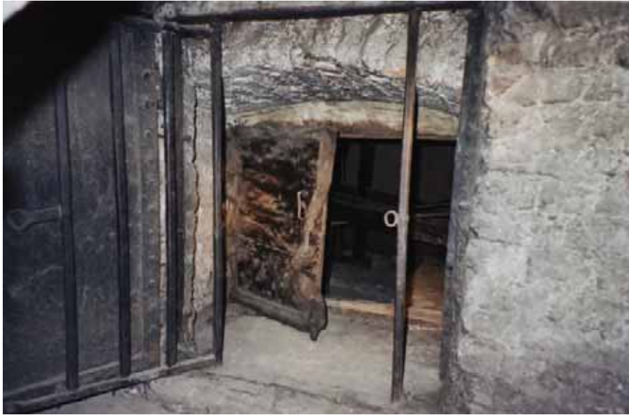
Bild 2: Winterpalast, Einstiegs Luke in die Decke über dem Wappensaal (Lorenz 2002)
