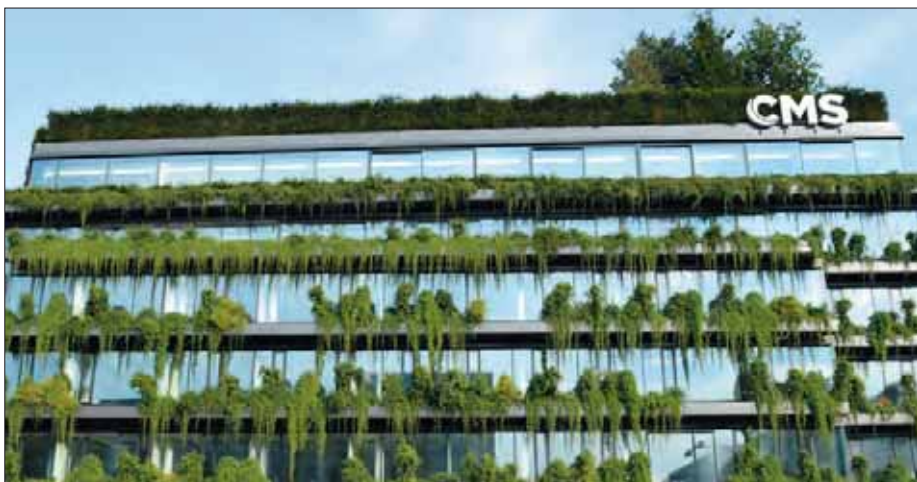
Architekt Christoph Ingenhoven geht in seinem Impulsvortrag auch auf seine bekannten Objekte KöBogen 2 und Calwer Passage (im Bild) ein.
