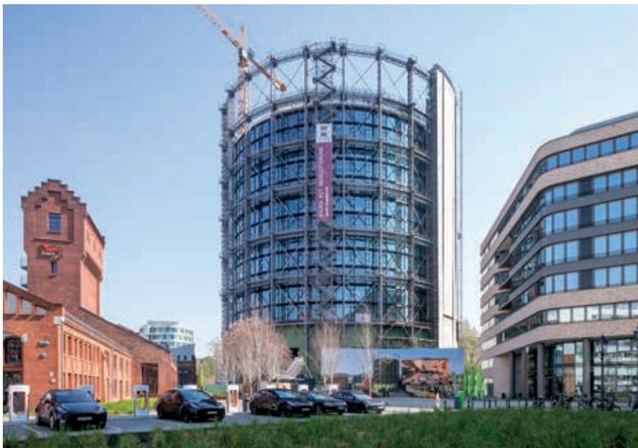
Richtfest auf dem EUREF-Campus: Das Großprojekt Gasometer liegt im Zeitplan.
