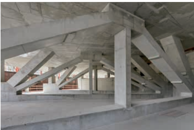
Große Sprengwerke sorgen dafür, dass der Konferenzbereich drunter stützenfrei bleiben kann.
