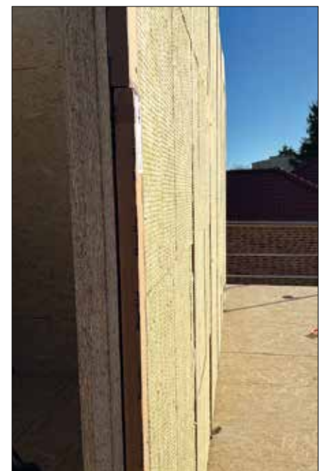
Aufbau der Wohnungstrennwand mit SWISS KRONO MAGNUMBOARD® OSB, PhoneStar Schalldämmung und Mineralwolle auf der Baustelle. (Bildnachweis: © SWISS KRONO | Foto: Michael Weithe)
