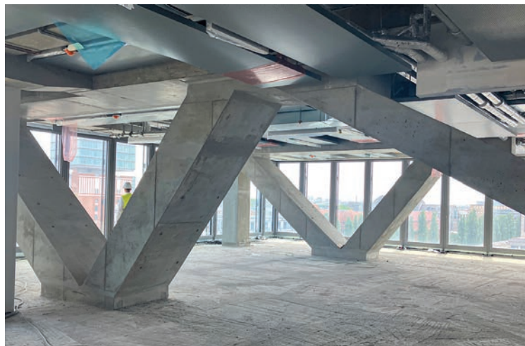
Abb. links: Blick auf die Auskragung von außen
