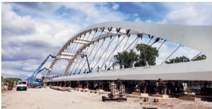
Blick auf die eingebauten Carbonhänger der Netzwerkbogenbrücke (Juli 2023) [Quelle: DB Netz AG]
