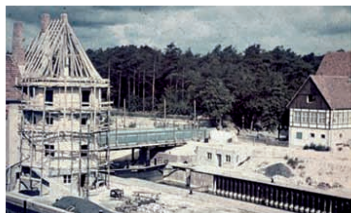
Schleuse Kleinmachnow, Bau der Nordkammer, um 1939, Archiv WSA
