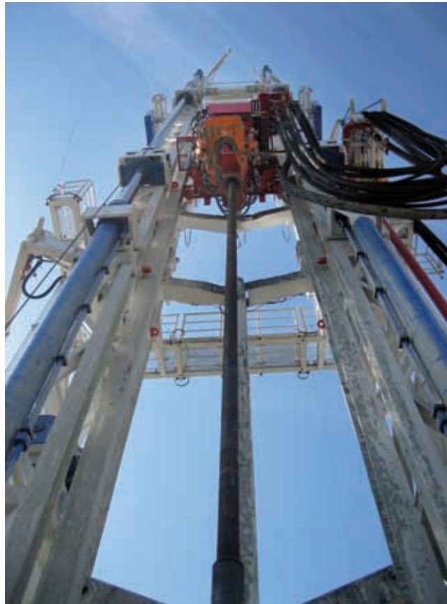
Abbildung 1: Tiefbohranlage im Einsatz bei einem Geothermieprojekt. Das Land Berlin plant Erkundungsbohrungen an 12 Standorten im Stadtgebiet.
