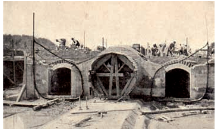
Trennungsfuge in der Mittelmauer
