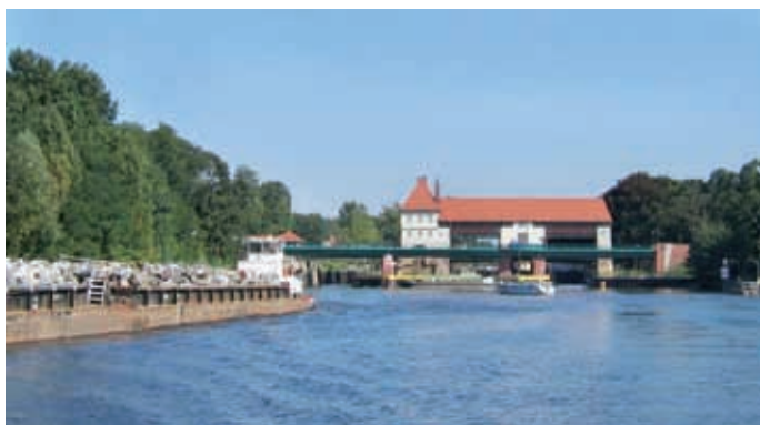
Schleuse Kleinmachnow, Brücke 2005
