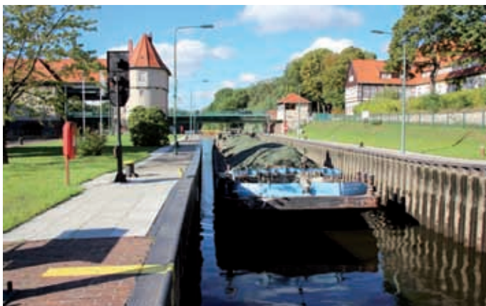
Schleuse Kleinmachnow mit Einfahrt in die Nordkammer durch Schubverband; beladen mit Holzschredder Richtung Berlin
