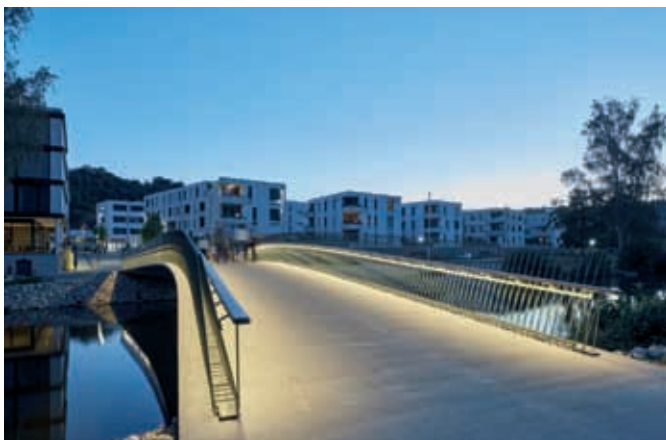
Neuer Herzogsteg über die Altmühl, Fuß- und Radwegbrücke © Bruno Klomfar
