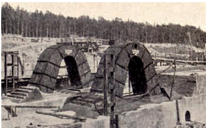
Unterhaupttheber der Mittelmauer
