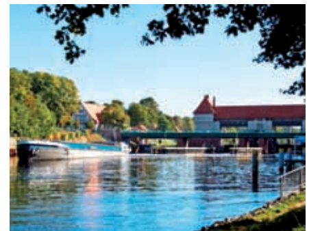
Schleuse Kleinmachnow mit Ausfahrt aus Nordkammer Richtung Potsdam
