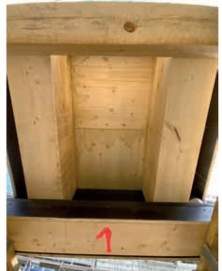
Abbildung 6: Durchfeuchtete Bereich an Modell 1
