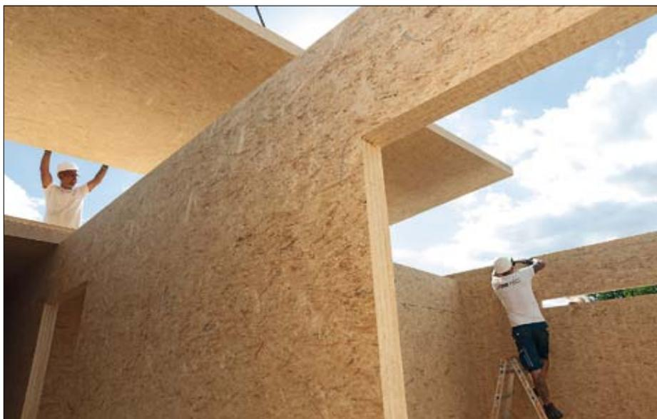
**Schneller Baufortschritt durch großformatige, vorgefertigte Wand- und Deckenelemente.**
