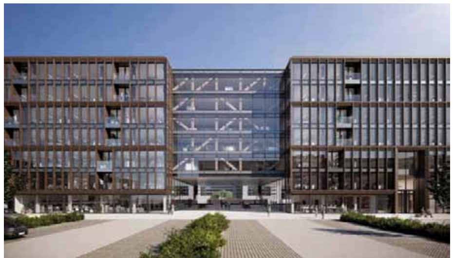
Optimierte Fachwerk-Diagonalen ermöglichen Durchgänge zwischen den einzelnen Bereichen. (Ansicht von der Stralauer Allee)
