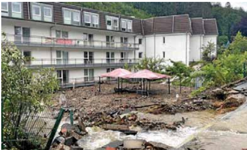
Abbildung 1: Schäden am Martha-Müller-Seniorenzentrum im Wesselbachtal (Krombusch, 2021)
