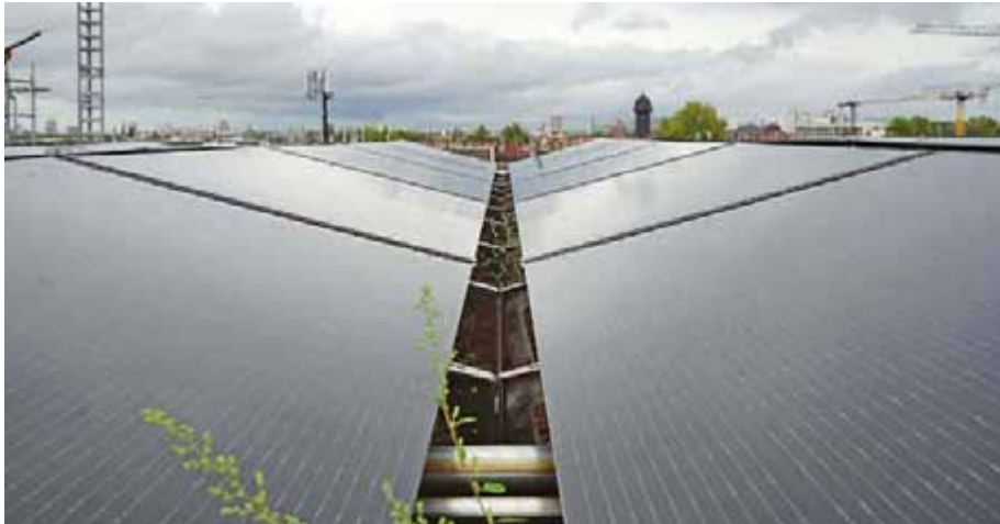
Die Anlage vereint Photovoltaik- und Solarthermiemodule (PVT) auf dem Dach des Dockyard und ist aktuell die größte Deutschlands.
