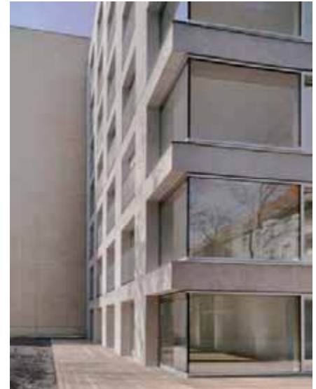
Bild 3: Das Wohnhaus wurde im Rahmen Architektur Preis Berlin 2023 ausgezeichnet.
