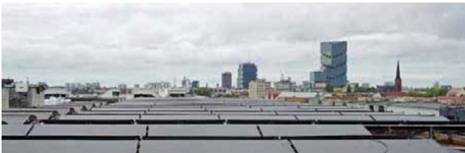
Die Anlage vereint Photovoltaik- und Solarthermiemodule (PVT) auf dem Dach des Dockyard und ist aktuell die größte Deutschlands.
