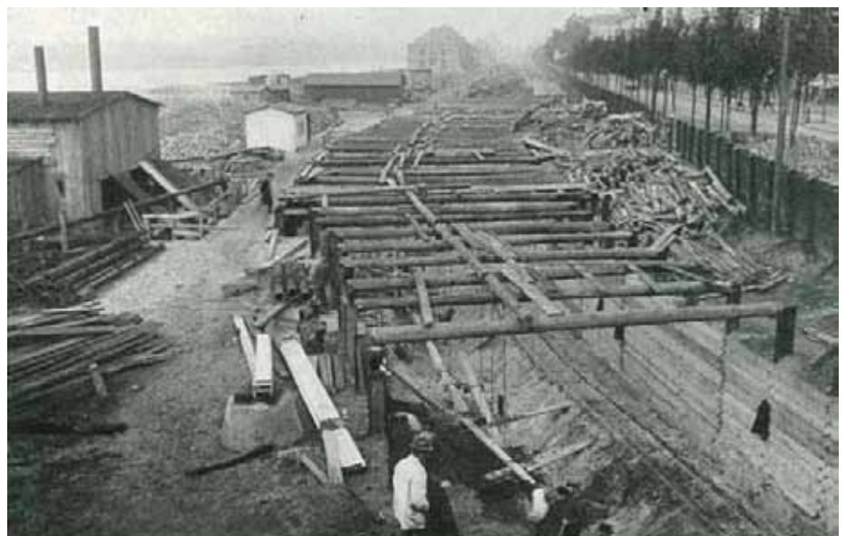
Bau der Anschlußgleisrampe auf dem Osthafengelände im September 1912
